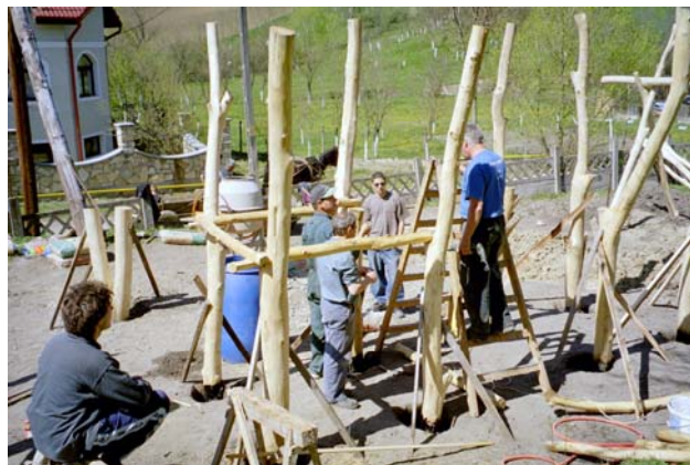
Gemeinsam bei Bau des Spielplatzes
